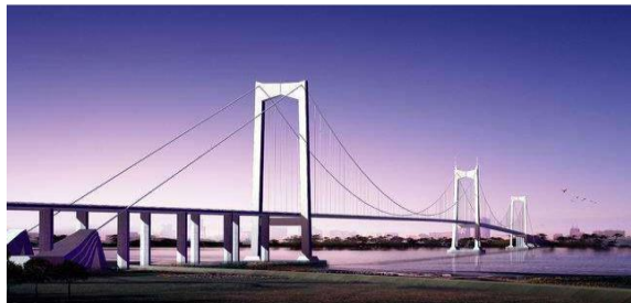
泰州长江大桥中塔 (69m×58m×52.8m) 砂层，无黏性土
