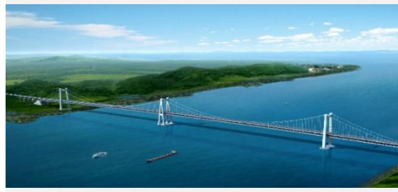
瓯江北口大桥南锚碇 (70.4×63×67.5m) 淤泥 厚度 40m
