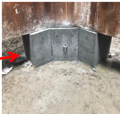
节点柔性支撑置换
