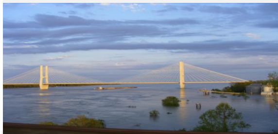
美国格林威尔大桥主塔沉井 (36m×24m×53m) 上覆土27m，黏土厚度 14m
