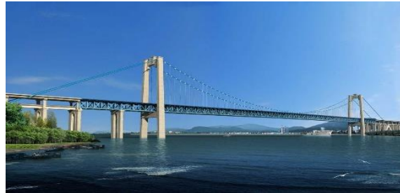
五峰山大桥北锚碇 (100.7m×72.1m×56m) 黏土厚度 12.7m
