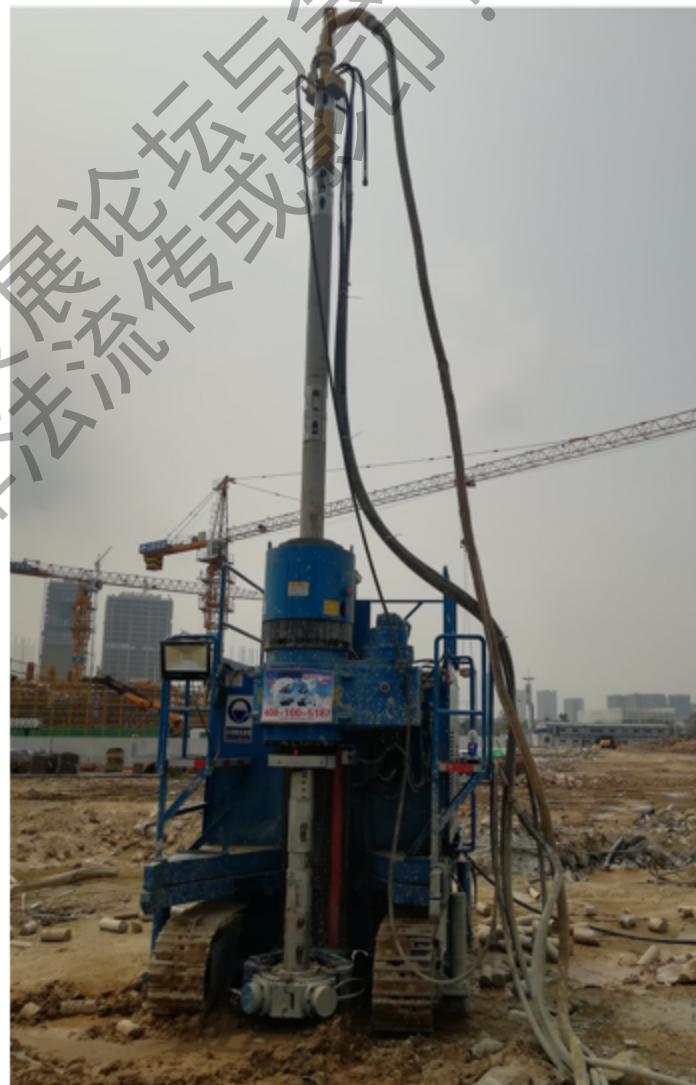
MJS钻 机、钻杆、 钻头
