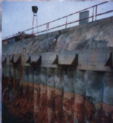
开挖现场及咬合桩桩体
