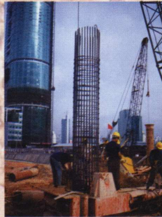
(四) 安装钢筋笼
