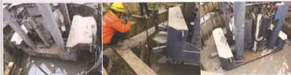
顶进装置携带根键入孔
