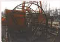
加强圈及上半圆主筋定位胎模安装
