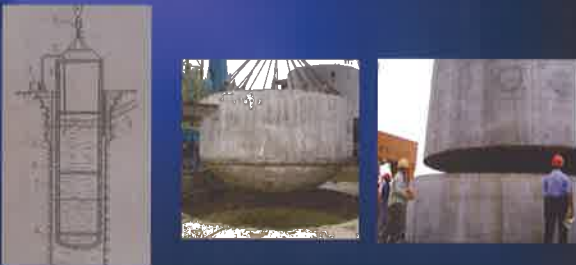
井壁漂浮下沉
