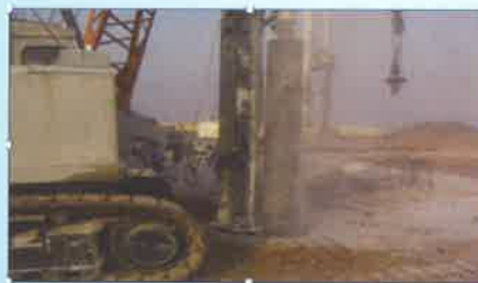
长螺旋钻机桩基孔正循环气动潜孔锤钻进现场
