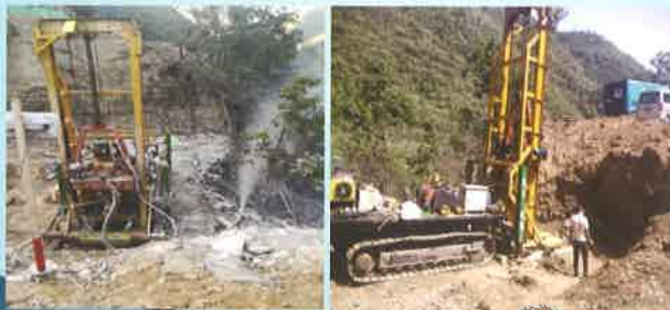
田野桩基履带式泵吸反循环钻机1.2米反循环潜孔锤钻进现场
