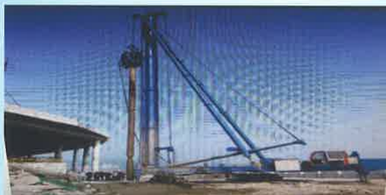
长螺旋钻机桩基孔粗钻杆正循环气动潜孔锤钻进现场
