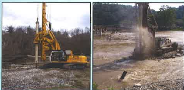
旋挖钻机正循环气动潜孔锤钻进现场
