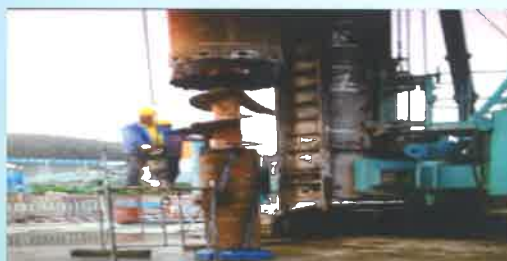
长螺旋双动力头钻机桩孔正循环潜孔锤跟管钻进现场
