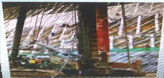
长螺旋钻机桩基孔炮弹衣钻杆正循环潜孔锤钻进现场
