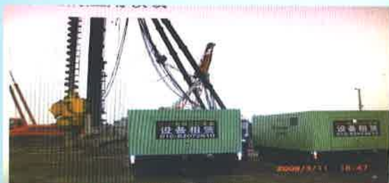
长螺旋钻机双动力头跟管正循环潜孔锤钻进现场
