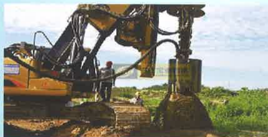
旋挖钻机正循环气动潜孔锤钻进现场
