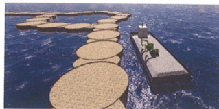
图 方驳上挖掘机抛石
