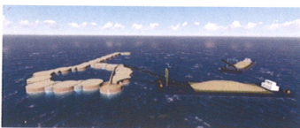
图 皮带船向筒内及副格仓内回填砂
