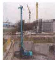
潜孔锤+旋挖钻机组合
