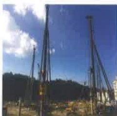
常州二区地下空间PPP示范项目
