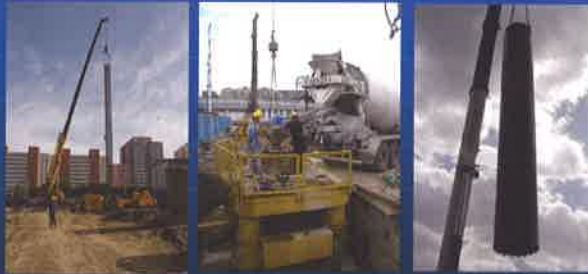
下试桩钢筋笼
