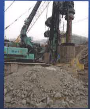
地层为山卵石抛填层，下部入风化岩层， 旋挖超前钻进，接管机跟进套管
