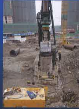
CGJ-2000S接管机在重庆创Φ1500 全套管钻挖68米的国内深度记录
