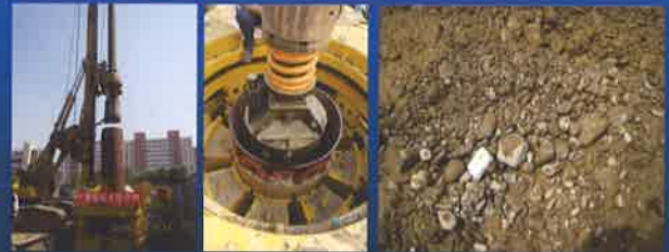
全回转套管+管内旋挖取土
