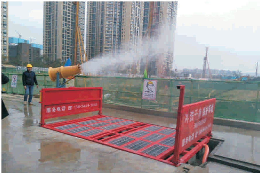
坑内作业区设置喷雾炮或可移动喷淋系统喷水雾
