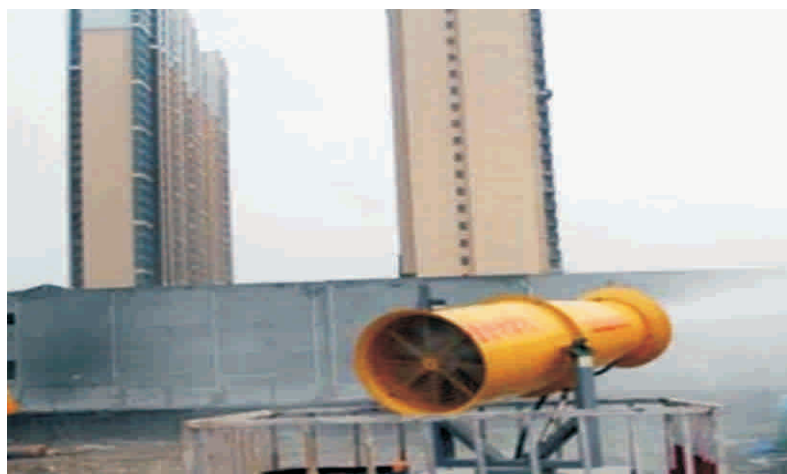
室外绿化作业区设置可移动喷淋系统或喷雾炮
