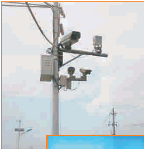
视频监控系统及出入车辆抓拍卡口相机
