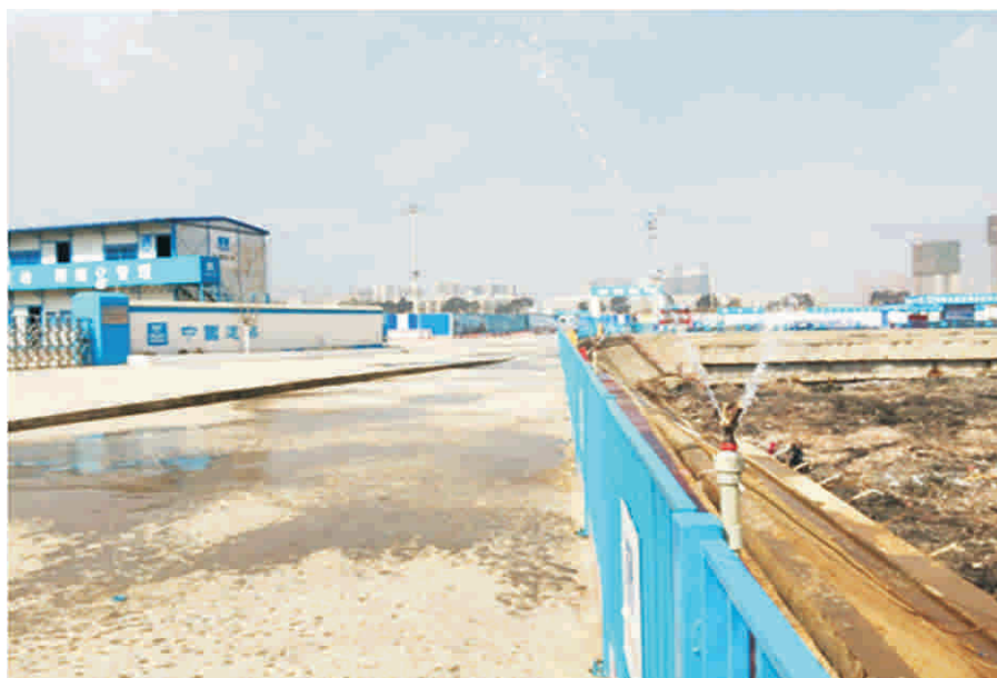
基坑周边喷淋整体实体图
