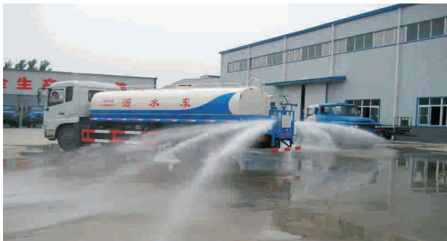
大型洒水车，对现场主要施工道路及时洒水降尘
