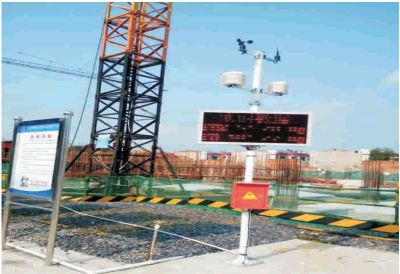
PM10自动检测装置及LED显示屏
