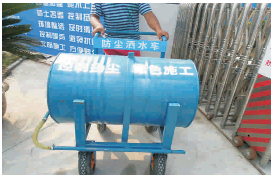
利用自制小型洒水车，对大型洒水车无法涉及的区域进行洒水降尘，确保施工场地内扬尘控制无死角。
