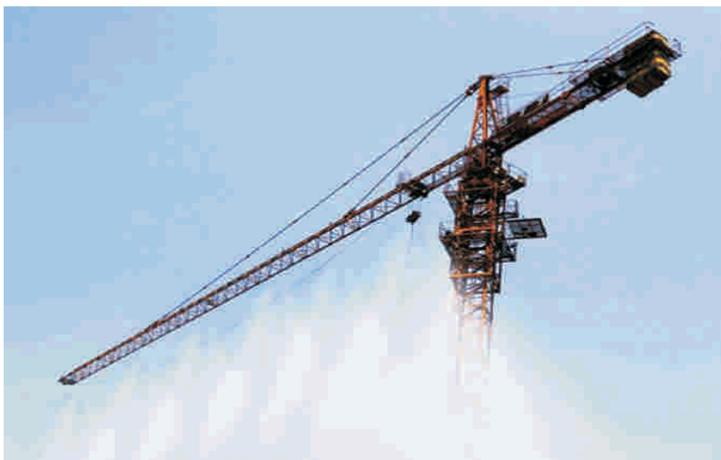
塔吊臂上设置喷淋系统
